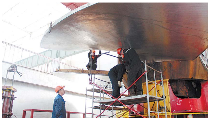
Сборка гидротурбины на монтажной площадке Чебоксарской ГЭС
