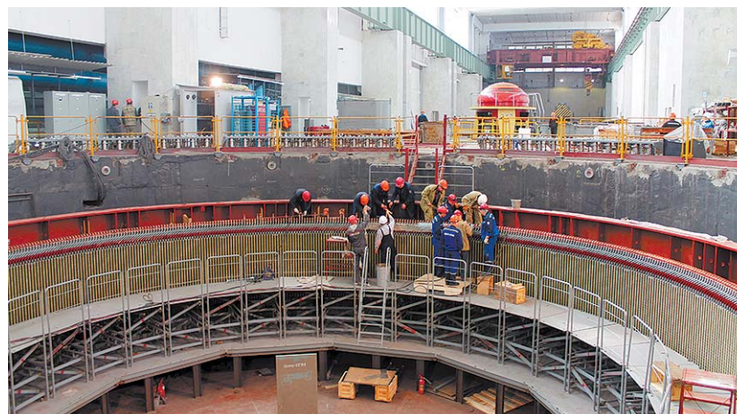
Сборка нового статора гидрогенератора
